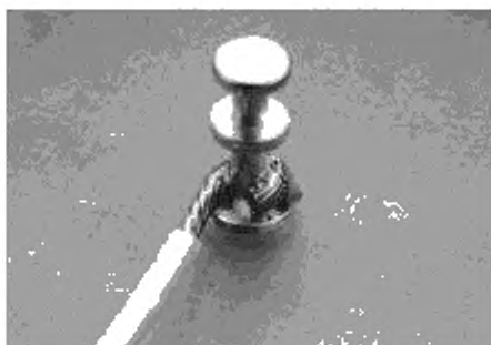
Рисунок 36 — Паяное соединение провода с контактом: недопустимое состояние
