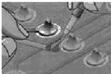
Рисунок 3 б — Удаление отвержденного покрытия с обрабатываемого участка
