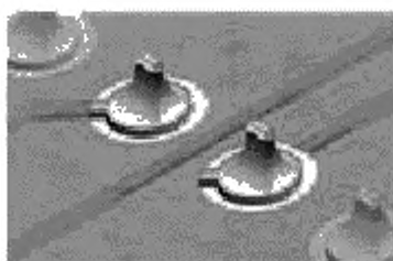
Рисунок 5 с — Удаление покрытия завершено
