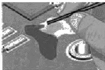
Рисунок 9 д — Создание текстуры поверхности пористым тампоном
