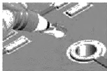
Рисунок 10 а — Удаление поврежденного материала фрезой
