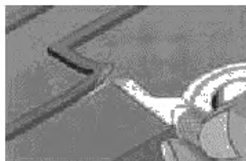
Рисунок 17 а — Нанесение эпоксидного состава под отслоившийся проводник
