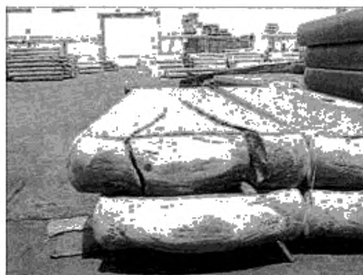
Рисунок А.8 — Трещина донная
