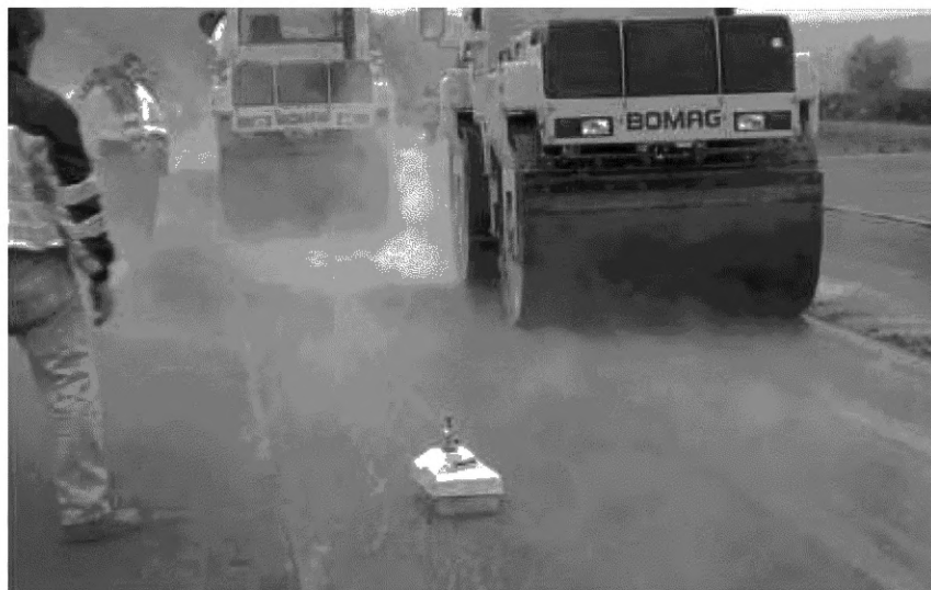
Рисунок С.10 — Дорожная группа. Финишер и два катка (первый проход статического уплотнения)
