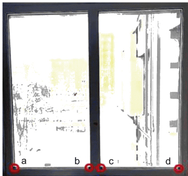
Фото оконного блока с установленным измерительным оборудованием
