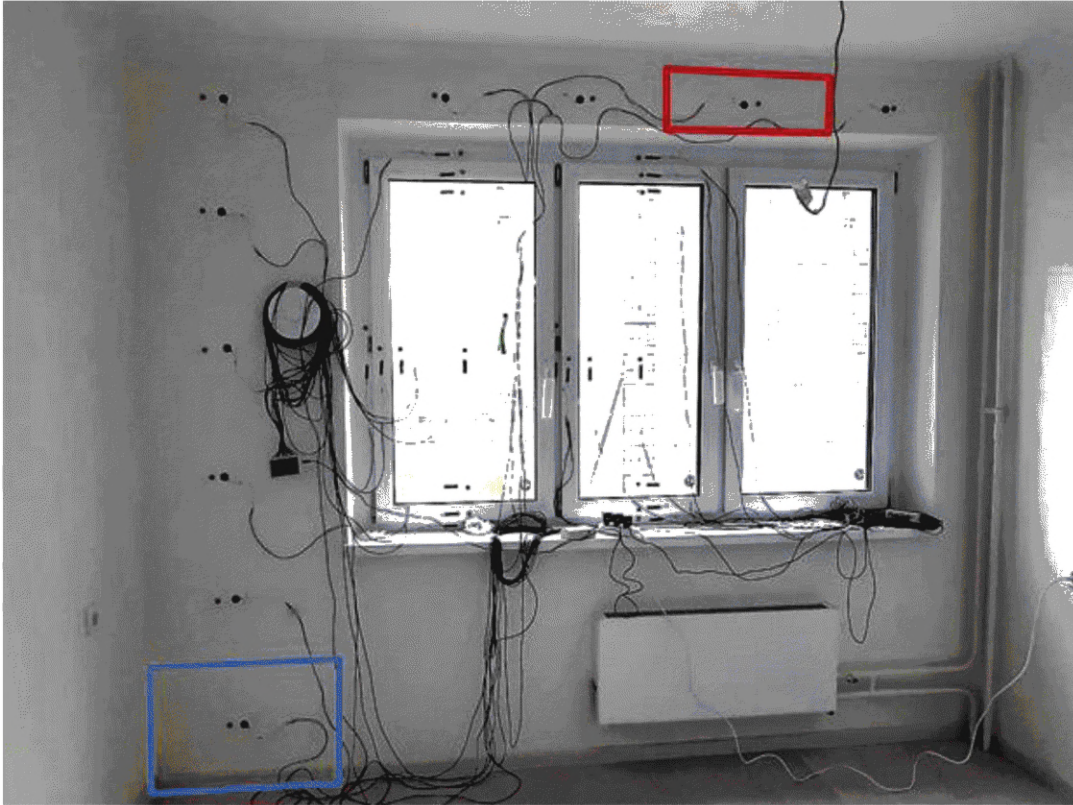
Фото 0.2. Стена (тип 1) с датчиками измерения теплового потока и температуры в осях 1—2 по оси В на 7-м этаже. Красным контуром выделена наиболее теплопроводная зона, синим — наименее.
