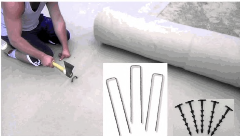
Рисунок 9 - Установка анкера на стыке геотекстиля (металлические и пластиковые анкеры для геотекстиля)
