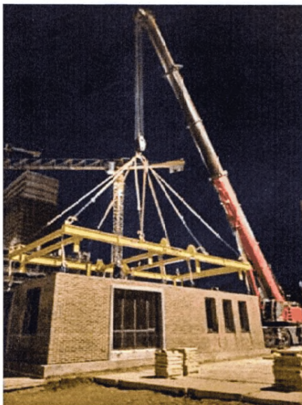
Рисунок 23.9 – Погрузка-выгрузка автомобильным или гусеничным краном
