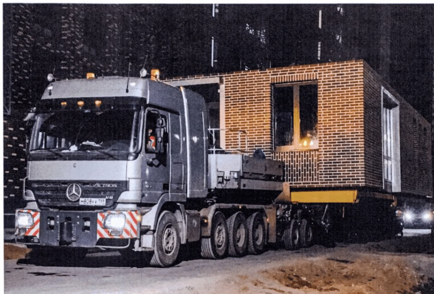
Рисунок 23.7 – Транспортирование модуля
