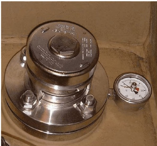
Рис. 8.1 Типичный предохранительный клапан с манометром
