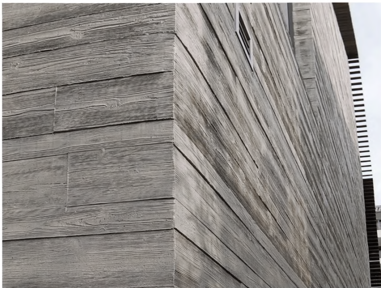
Рисунок 2 – Пример эффективного использования простой дощатой опалубки для реализации архитектурно-художественного решения
