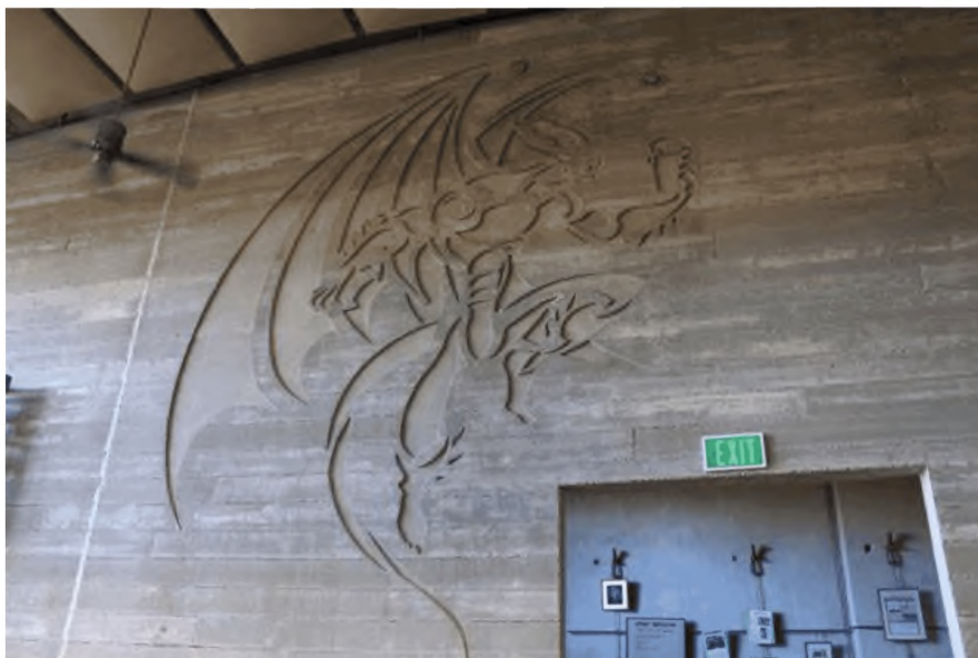
Рисунок 3 – Комбинирование простой дощатой опалубки и формообразующих вкладышей
