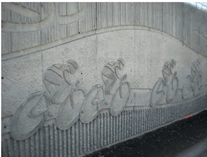
Рисунок 1 – Примеры сложных поверхностей, полученных при использовании формообразующих элементов опалубки
