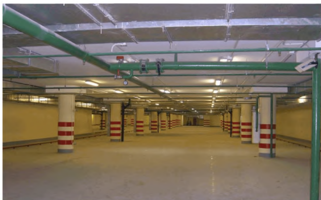
Рисунок 1 – Общий вид закрытой подземной стоянки автомобилей с
