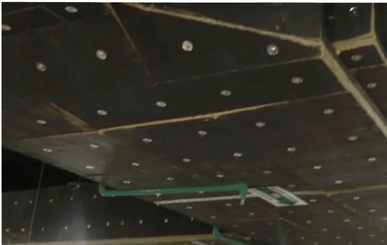
Рисунок 21 – Расположение спринклерных оросителей под воздуховодами дымоудаления
