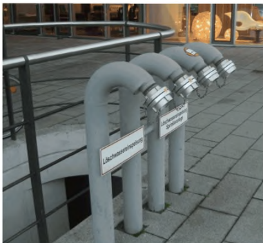
Рисунок 22 – Пример установки соединительных головок снаружи здания
