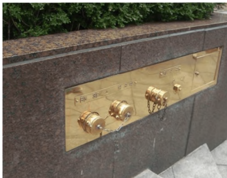
Рисунок 22 – Пример установки соединительных головок снаружи здания
