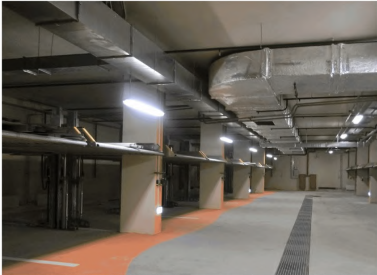
Рисунок 14 – Расположение дренажных лотков в полу нижнего уровня механизированной стоянки автомобилей
