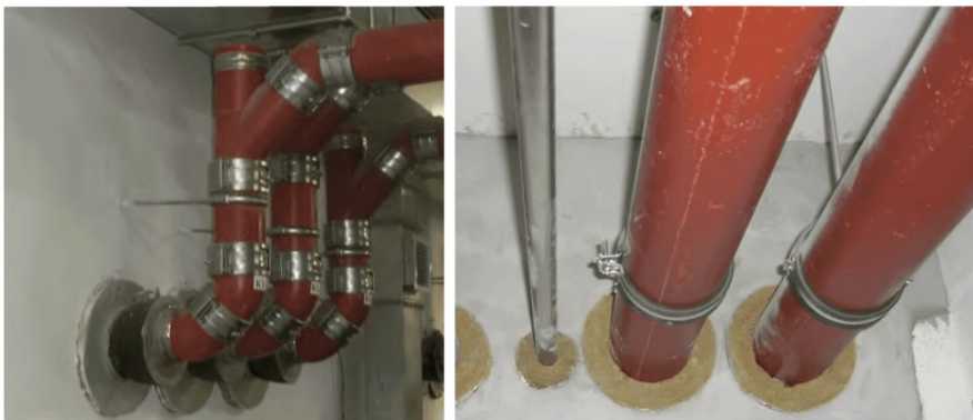
а – устройство канализационных выпусков в наружных стенах стоянки автомобилей, б – узел прохода чугунных трубопроводов через противопожарные преграды
