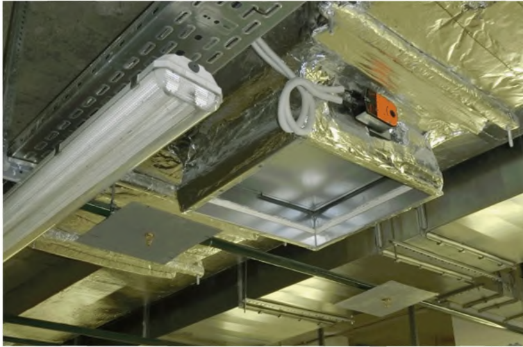
Рисунок 9 – Пример установки противопожарного клапана для удаления продуктов горения
