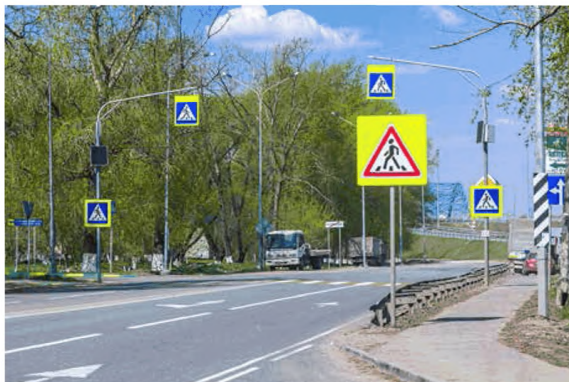
Рисунок 4.4 Пример расположения дорожных знаков 5.19.1 над проезжей частью
