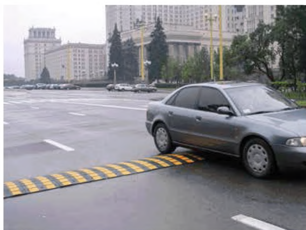
Рисунок 4.27 – Примеры использования соответственно сборно-разборной и монолитной искусственной неровности
