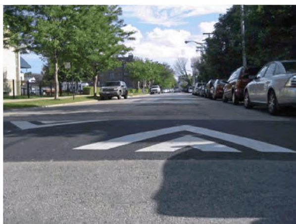
Рисунок 4.27 – Примеры использования соответственно сборно-разборной и монолитной искусственной неровности
