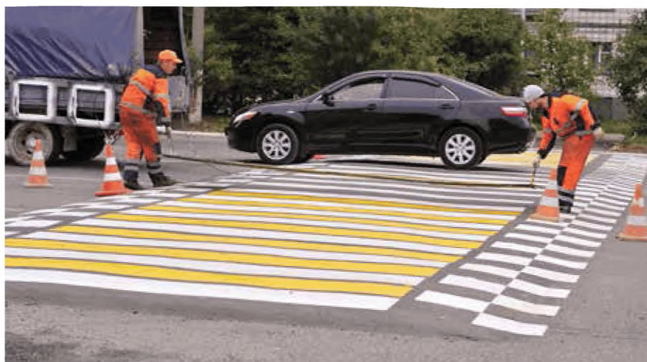
Рисунок 4.28 – Пример использования приподнятого пешеходного перехода
