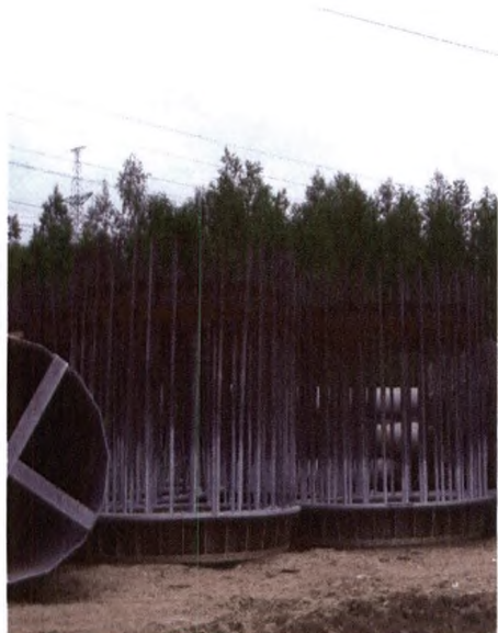
Детали фундамента: ЗДМ и сваи – оболочки.
