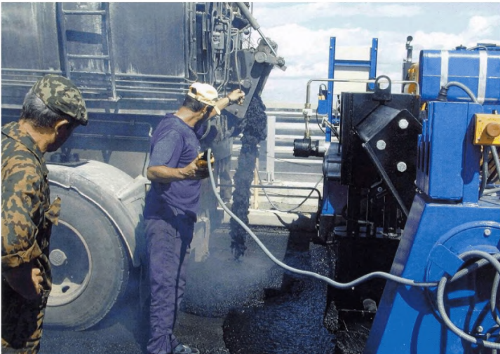
Рисунок В.12 - Выдача литого полимерасфальтобетона из котла «кохер» для укладки
