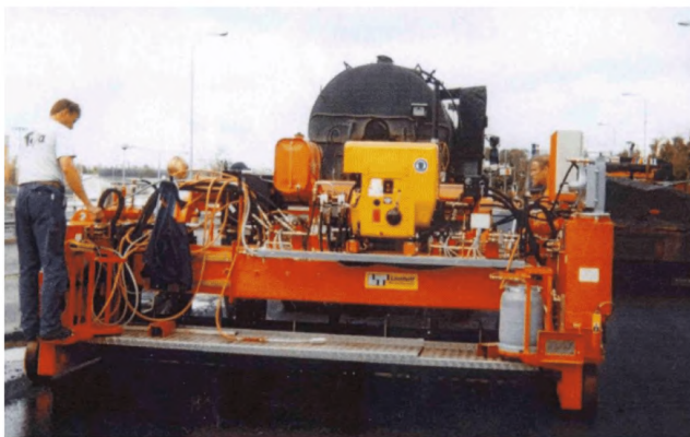
Рисунок В.13 - Укладка литого полимерасфальтобетона типа I по асфальтобетону
