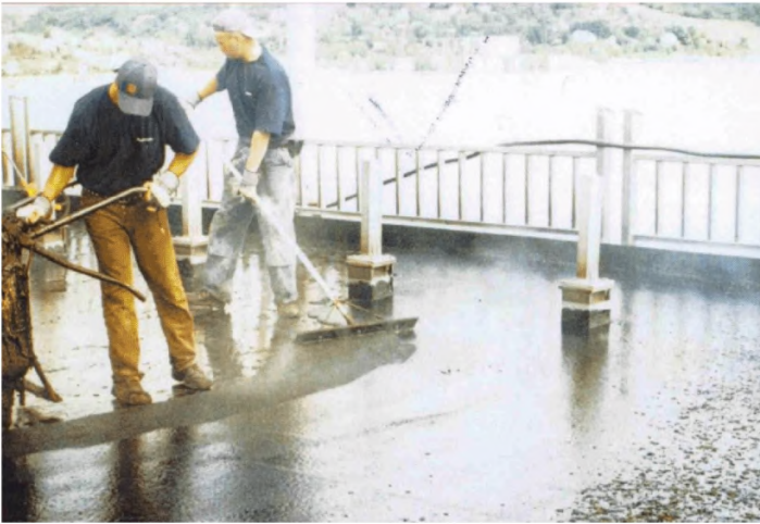
Рисунок В.11 - Укладка гидроизоляционной мастики по полимербитуму
