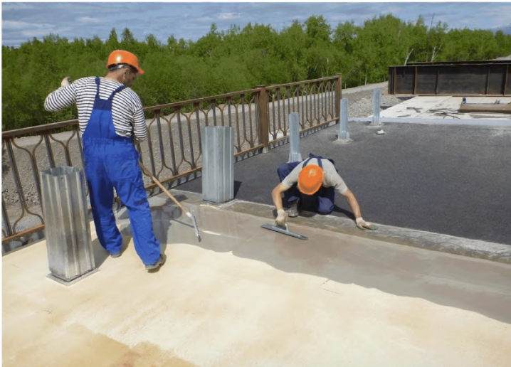
Рисунок В.18 – Нанесение основного износостойкого слоя «Matacyl WL®»
