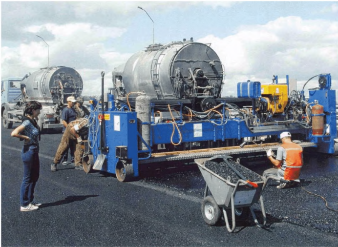
Рисунок В.7 - Асфальтоукладчик и котлы «кохеры»
