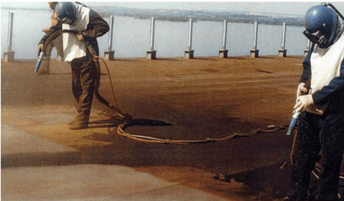
Рисунок В.8 - Пескоструйная очистка поверхности ортотропной плиты
