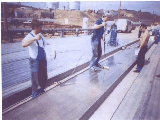
Рисунок В.16 – Нанесение праймера «Matacryn Primer CM®», присыпка песком
