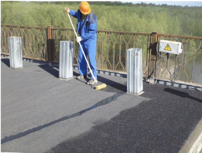
Рисунок В.21 – Нанесение финишного лака «Matacyl STC®»
