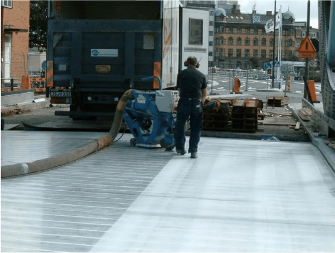
Рисунок В.15 - Подготовка поверхности шлифовальными машинами с металлическими щетками, снабженными пылесосами
