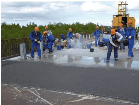
Рисунок В.20 - На заднем плане нанесение основного износостойкого слоя «Matacryn WL®», на переднем плане присыпка еще не полимеризовавшегося слоя корундом, работы идут одновременно
