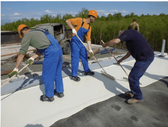
Рисунок В.17 - Нанесение демпфирующего слоя – мастики «Matacryl Manual®»
