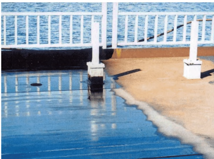
Рисунок В.9 - Покрывной слой из разжиженного полимербитума по поверхности ортотропной плиты
