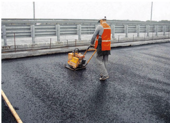
Рисунок В.14 - Втапливание очерненного щебня в литой асфальтобетон в зоне деформационного шва
