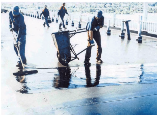
Рисунок В.10 - Разлив полимербитума по разжиженному полимербитуму
