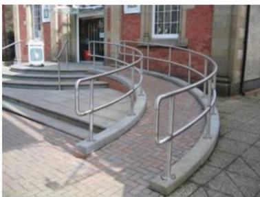
Рисунок 6.42 – Винтовые (криволинейные) пандусы применять не рекомендуется
