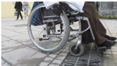
Рисунок 5.23 – Возможно застревание колес в продольных отверстиях решетки
