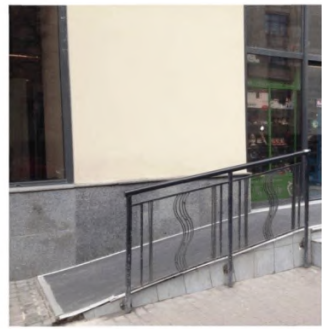
Рисунок 6.40 – Недопустимые решения по установке поручней на пандусе
