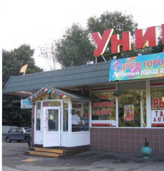
Рисунок 6.9 – Недопустимое решение входной площадки для доступа инвалидов
