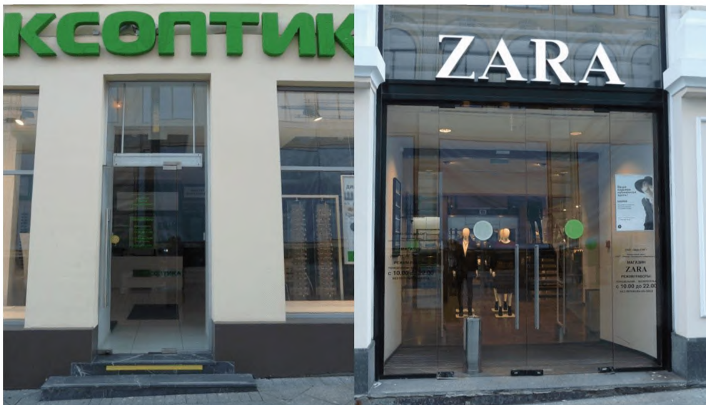
Отсутствие маркировки на стеклянных полотнах дверей недопустимо
