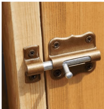
не обеспечивает открывание двери снаружи при несчастном случае
