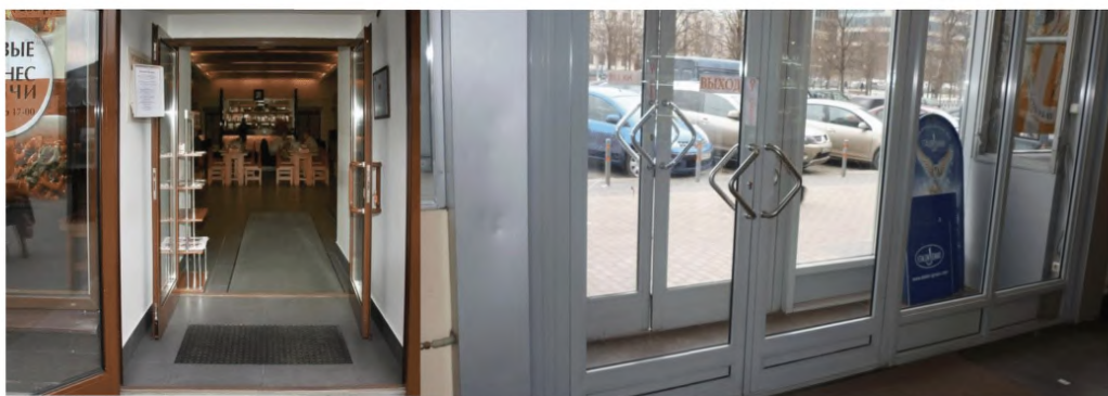
Рисунок 6.70 – Примеры тамбуров, через которые проход на кресле-коляске будет невозможен без помощи сопровождающего
