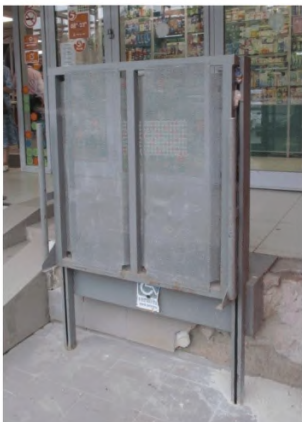
Рисунок 6.47 – Недопустимые конструкции подъемных платформ для инвалидов
