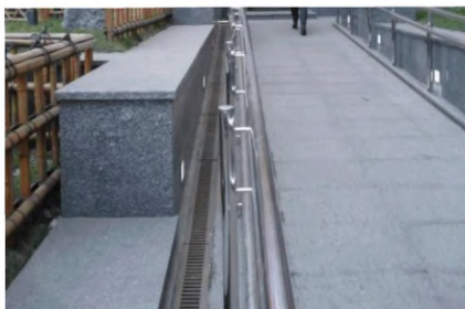
Вдоль сплошного ограждения пандуса идет водоприемная решетка
