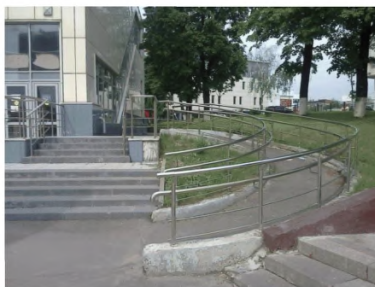
Рисунок 6.42 – Винтовые (криволинейные) пандусы применять не рекомендуется
