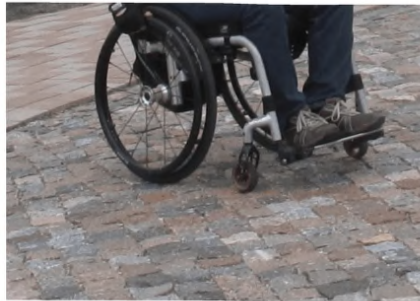
Рисунок 5.2 – Некомфортные для инвалидов виды покрытий пешеходных путей движения
