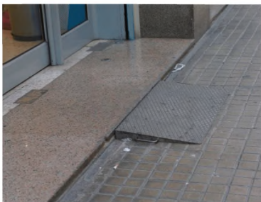
Рисунок 6.3 – Решение входной площадки с приставным пандусом
