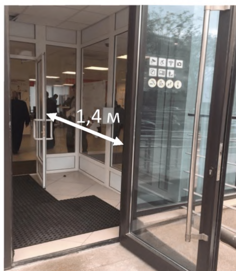
Тамбур при движении с поворотом и одностороннем открывании дверей
