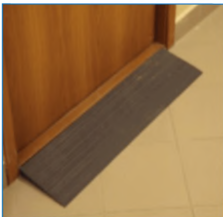
Рисунок 6.73 – Использование приставных резиновых мини пандусов для сглаживания существующих порогов
