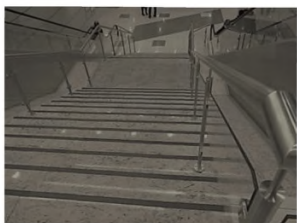
Рисунок 6.85 – Допустима маркировка контрастным материалом всех ступеней марша
