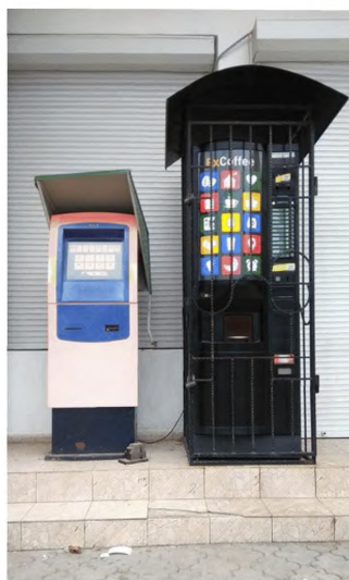
Не обеспечен безбарьерный подход к автомату
