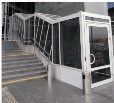
Рисунок 6.48 – Примеры применения подъемных платформ на входных группах объектов обслуживания
