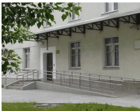
Рисунок 6.11 – Защитный козырек над пандусом
