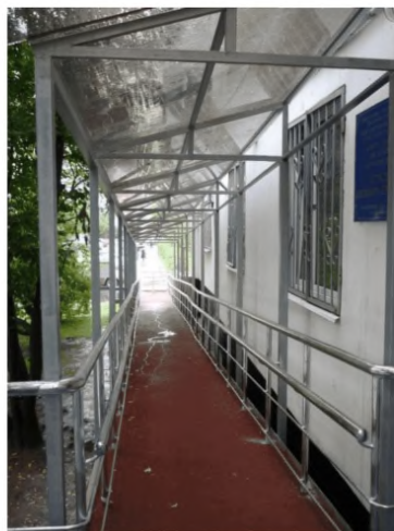
Рисунок 6.11 – Защитный козырек над пандусом
