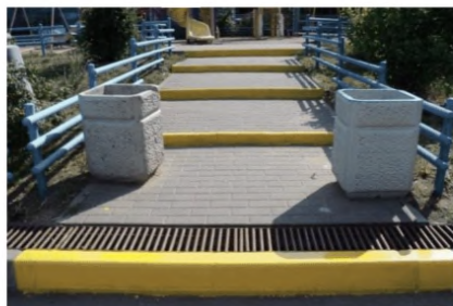
Рисунок 5.23 – Возможно застревание колес в продольных отверстиях решетки
