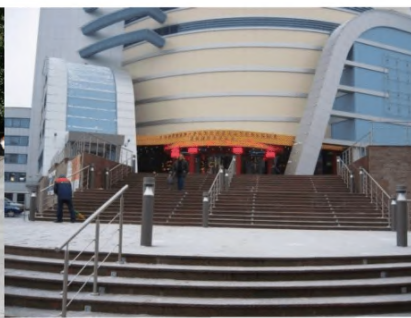
Разделительные поручни не имеют горизонтальных нетравмирующих завершений
