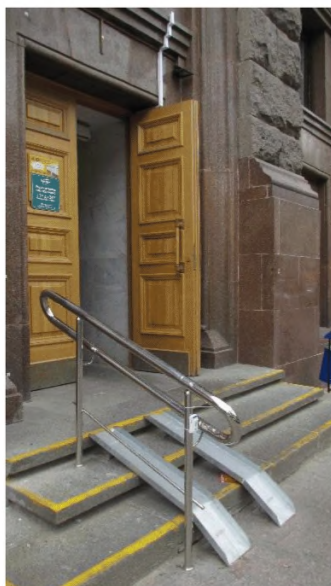
Рисунок 6.31 – Недопустимые на путях движения инвалидов конструкции (аппарели)
