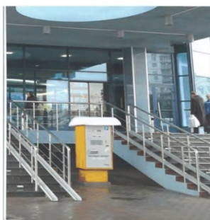
Рисунок 6.30 – Недопустимые конструкции входных пандусов для инвалидов
