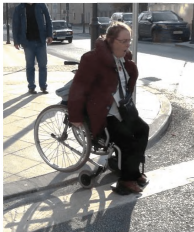
Рисунок 5.12 – Травмоопасная ситуация для человека в кресле-коляске при крутом спуске
