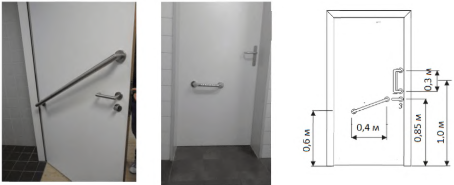
Рисунок 9.10 – Ручка-скоба поперек двери в санузле для облегчения закрывания двери изнутри кабины
