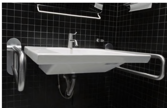
Рисунок 9.8 – Раковина в санузле для инвалида на кресле-коляске
