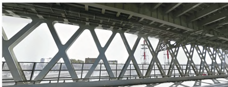
Рисунок А.2 — Пример совмещения (замещения) несущих элементов шумозащитного экрана с несущими элементами пролетов
