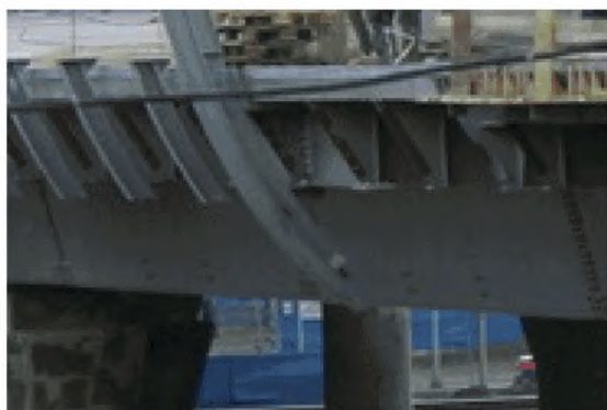
а — ШЭ, установленный на опорной стене (стандартное крепление); б — ШЭ, закрепленный на закладной трубе, проходящей вдоль всего пролета эстакады (аналог выносной площадки); в — крепление точечных выносных площадок на металлические ребра жесткости пролета эстакады под стойки ШЭ (торцевое крепление); г — крепление стоек ШЭ на закладные элементы в железобетонном пролете моста (стандартное крепление)
