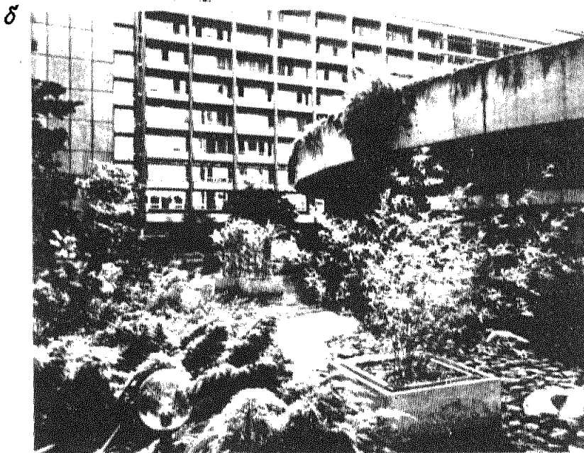
Рис.83. Примеры повышения архитектурной выразительности плоских кровель зданий а – путем устройства декоративных водоемов; б – путем использования травянистых и кустарниковых зеленых насаждений
