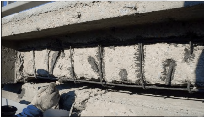
Рисунок 14 – Обработка металлических деталей и арматуры
