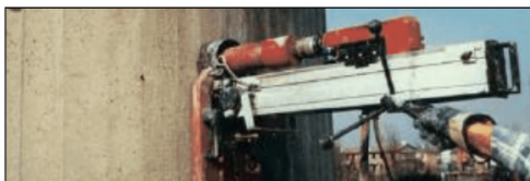
Рисунок 6 – Разрушающий контроль: отбор образцов керна
