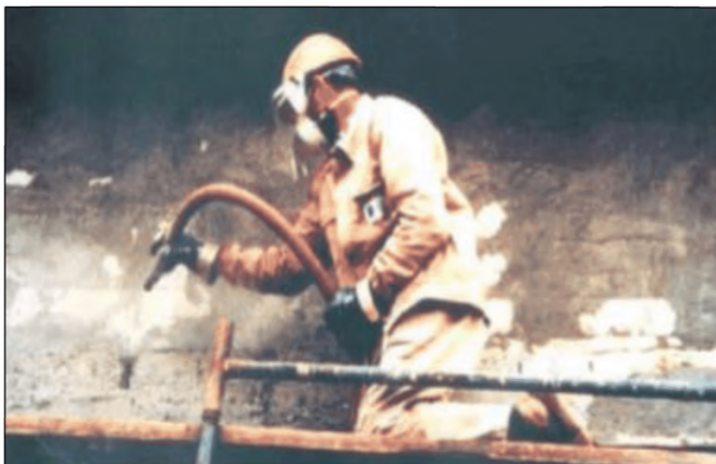
Рисунок 12 – Очистка поверхности с помощью пескоструйной установки
