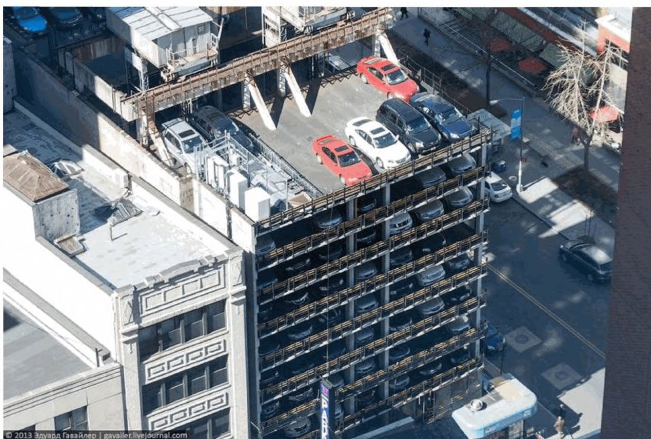
Рисунок 5 – Размещение стоянки в пристройке к жилому зданию
