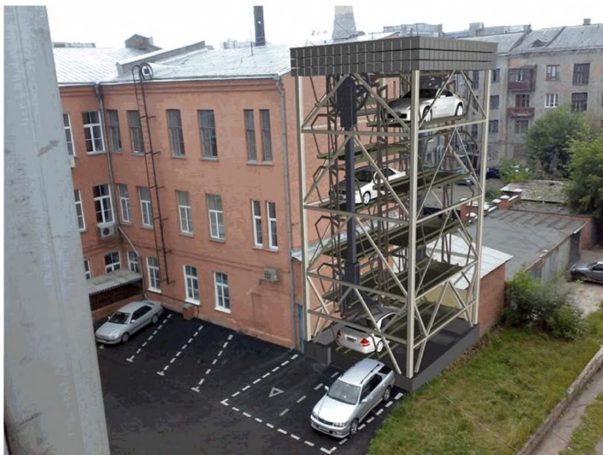
Рисунок 39 Пристроенная к глухой стене здания механизированная стоянка.
