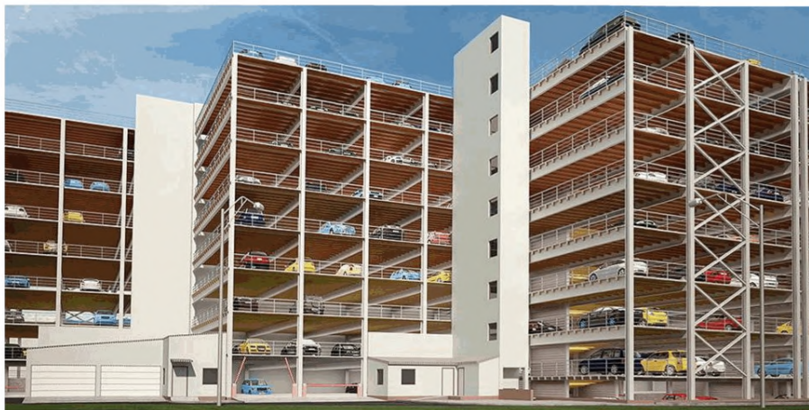
Рисунок 34 – Лестничные клетки в стоянках открытого типа
