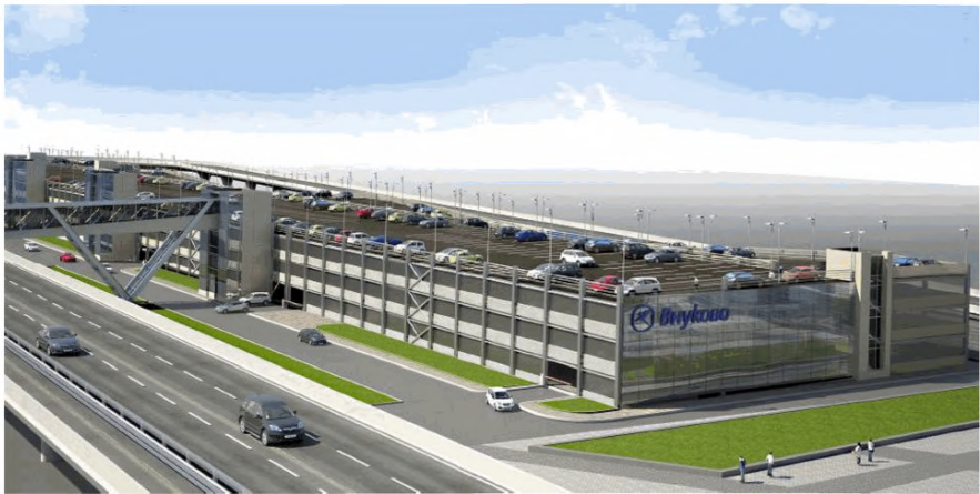
Рисунок 9 – Примеры стоянок автомобилей на эксплуатируемой кровле без установки навеса
