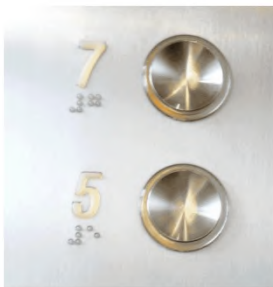
Рисунок 6.6.12 – Рельефные цифры на пульте управления лифта
