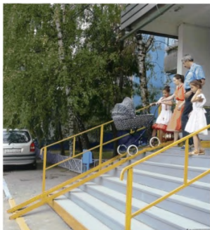
Рисунок 6.1.28 – Применение аппарелей для инвалидов недопустимо
