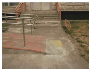
Рисунок 6.1.26 – Опасная зона перед спуском пандуса
