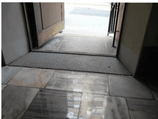
Рисунок 6.2.5 – Порог с мини-пандусом
