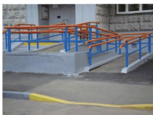
Рисунок 6.1.26 – Опасная зона перед спуском пандуса
