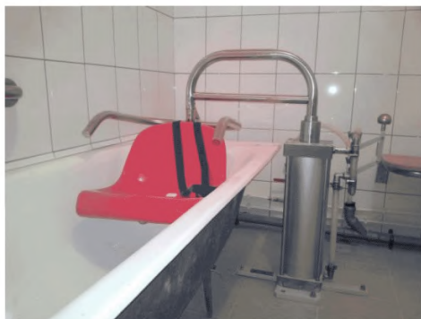
Рисунок 6.7.4 – Гидравлический подъемник для использования в ванной комнате
