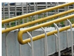
Рисунок 6.1.21 – Недопустимые конструкции креплений поручней на пандусе
