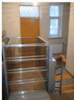
Рисунок 6.5.1 – Вход в спецквартиру для инвалида и холл квартиры с подъемником
