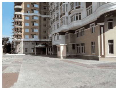
Объединение транспортного проезда и тротуара на придомовой территории
