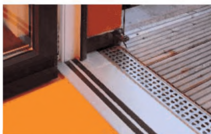
Рисунок 6.5.11 – Устройство фальшпола на балконе для уменьшения высоты порога
