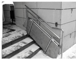
Рисунок 6.1.19 – Откидной пандус на внешней лестнице
