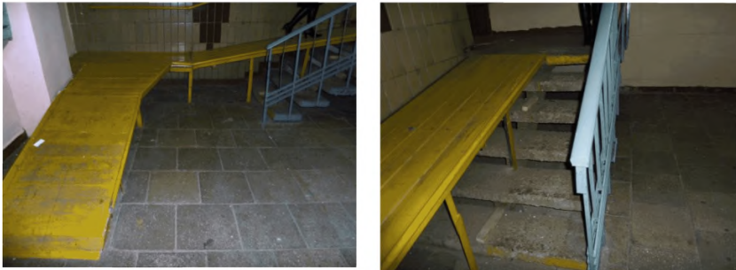
Рисунок 6.2.14 – Пандус в габаритах вестибюля жилого дома
