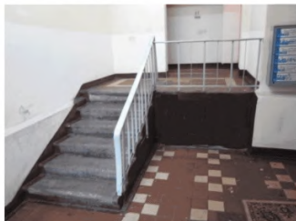
Рисунок 6.2.24 – Свободная площадка для установки вертикальной платформы
