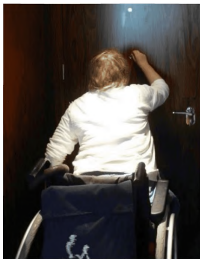
Рисунок 6.5.5 – Два глазка на входной двери на разной высоте
