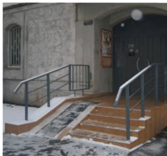
Рисунок 6.1.28 – Применение аппарелей для инвалидов недопустимо
