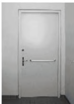
Рисунок 6.5.6 – Дополнительная ручка с внутренней стороны полотна
