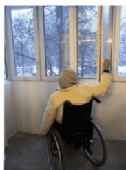
Низкое расположение оконной фурнитуры
