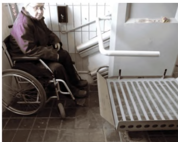
Откидывающийся пандус для заезда на наклонную платформу.
