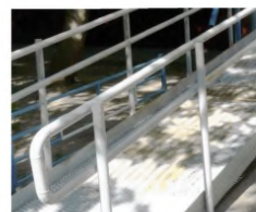
Рисунок 6.1.21 – Недопустимые конструкции креплений поручней на пандусе
