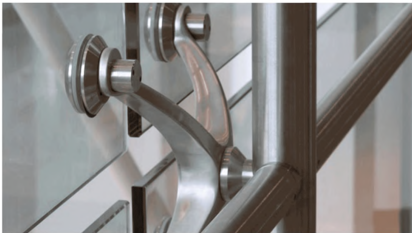
Рисунок 5.7 – Фрагмент спайдерного остекления
