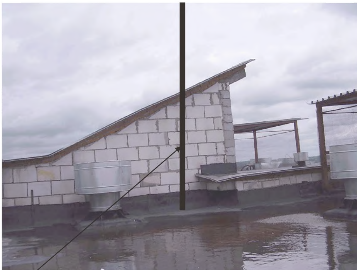
Рис. В6 Возможное место установки мачты приемной антенны. Высота мачты должна быть на (3-5) м выше края металлической крыши.
