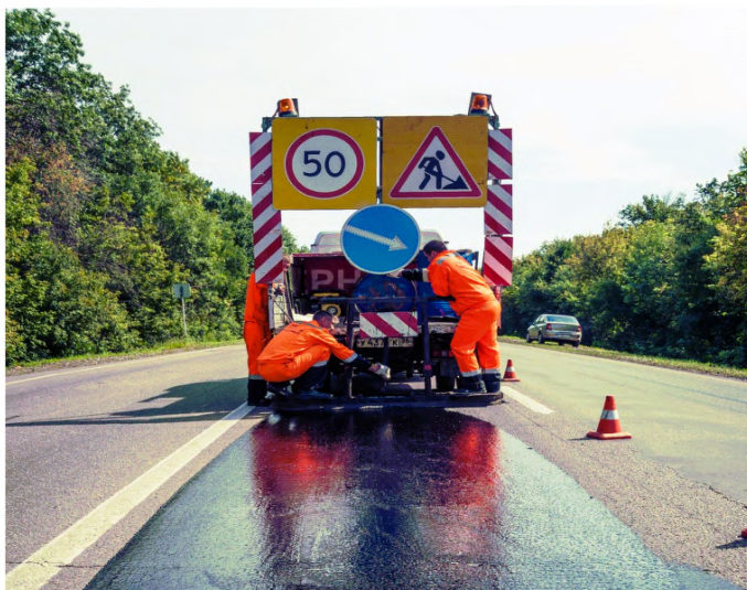
Рисунок 5 – Распределение пропиточного состава с помощью специально оборудованной машины
