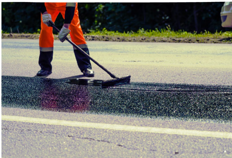
Рисунок 6 – Распределение пропиточного состава вручную
