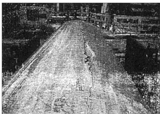
Рисунок А.4 — Трещина радиальная в полом слитке
