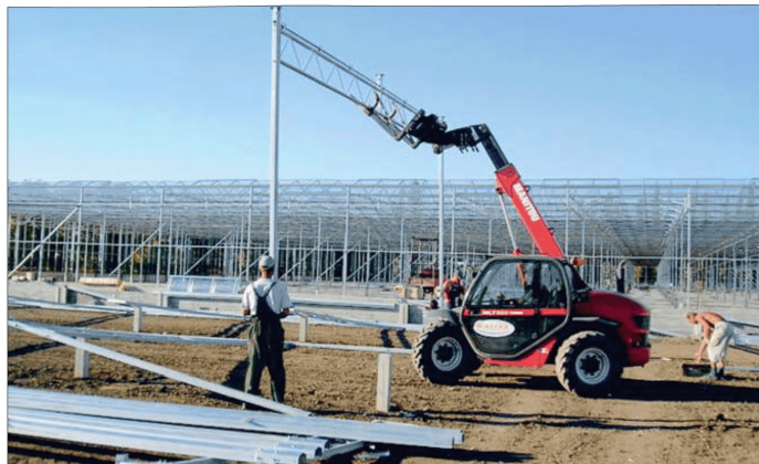
Монтаж каркаса теплицы
