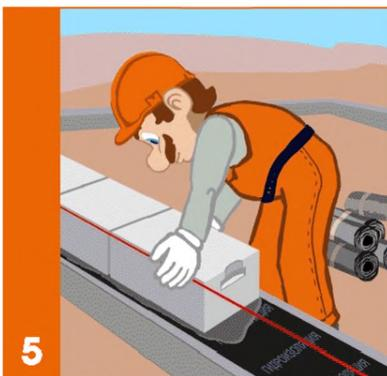
От выполнения кладки первого ряда блоков зависит качество всего дома. Между фундаментом и кладкой необходимо выполнить гидроизоляцию по верхней отметке фундамента. Первый ряд блоков следует укладывать на выравнивающий слой цементно-песчаного раствора.
