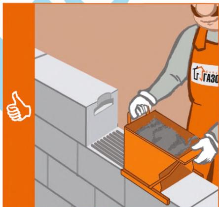
**Коретка** для клеевого раствора предназначена для нанесения клея на горизонтальную поверхность блоков во время кладки. Коретка позволяет дозировать клей, обеспечивая одинаковую толщину шва по всей кладке. Наиболее продуктивно использование кореток при кладке длинных и прямых стен. Выпускается шириной 300 и 400 мм.
