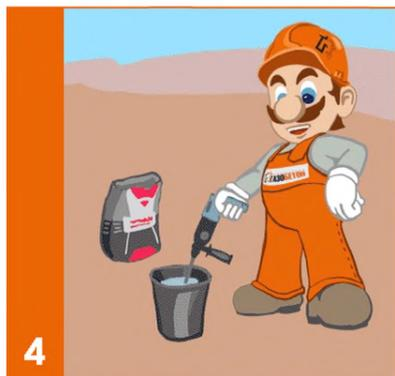
Для изготовления клея в ведро с отмеренным количеством воды, при постоянном перемешивании дрелью с миксером (см. инструменты), постепенно добавляют сухую смесь. В ходе работы клей периодически перемешивают для поддержания однородной консистенции раствора.
