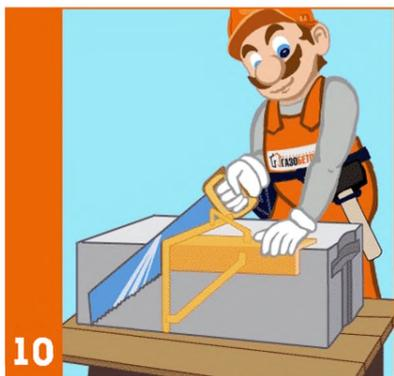
Доборные блоки легко выпиливаются при помощи ножовки (см. инструменты). Для обеспечения точности резки блоков и соблюдения прямых углов применяется угольник (см. инструменты). Использование для распилки электрической ленточной пилы гарантирует высокую точность подрезки блоков.
