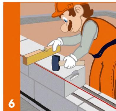
Установка каждого блока контролируется по уровню и шнуру-причалке. Для точного позиционирования блоков в кладке используется резиновая киянка (см. инструменты).
