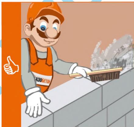
**Щетка-сметка** предназначена для очистки поверхности от пыли. Применяется после шпательной обработки блока, перед грунтовкой и окраской поверхности стен.
