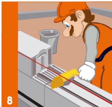
При использовании блока с системой паз-гребень тычок промазывается по 5 см от края с каждой стороны.
