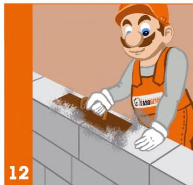
После укладки очередного ряда блоков поверхность выравнивается с помощью рубанка для газобетона (см. инструменты). Перепады между соседними блоками не допускаются.
