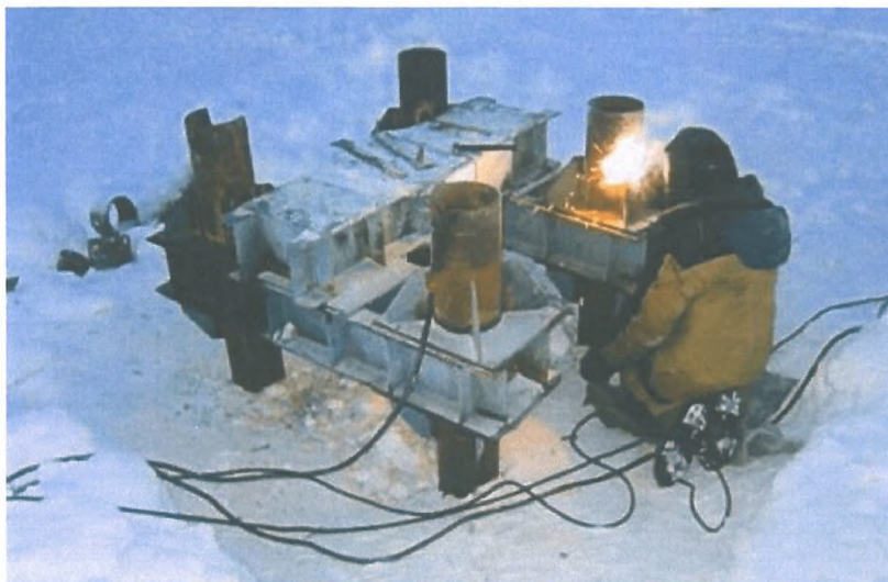
Рис.4.1 – Установка четырёхсвайного сварного ростверка для ноги опоры ВЛ
