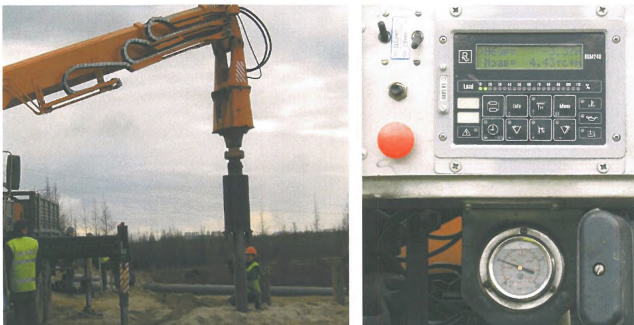
Рис.2.6 - Завинчивание сваи с контролем вертикальности; приборный щиток
