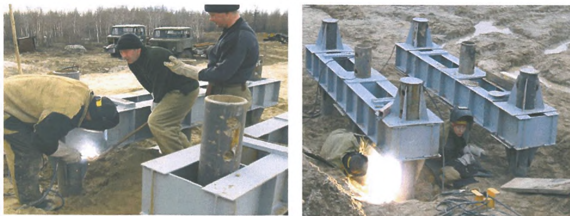
Рис.2.12 - Выполнение основных сварочных работ ручной сваркой в 2 поста; выполнение сварочных работ в трудном нижнем положении.
