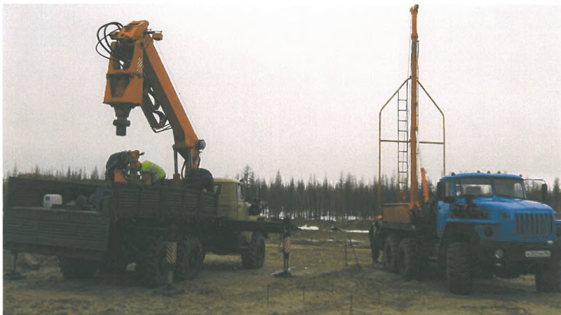
Рис.2.4 - Подготовка машины УБМ-85 (установка аутригеров, навеска патрона)
