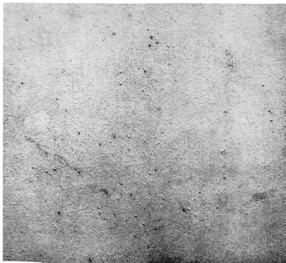
Рисунок 9 — Коррозия металла балл K1 (или R1)
