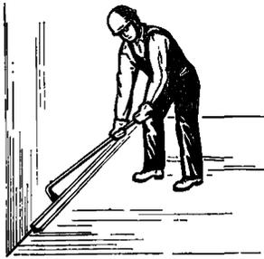
Рис. 30. Отрыв плинтуса от стены
