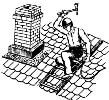
Рис. 14. Вырубка стяжки в примыкании кровли к дымовой трубе
