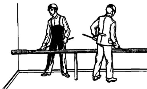
Рис. 50. Снятие изоляции
