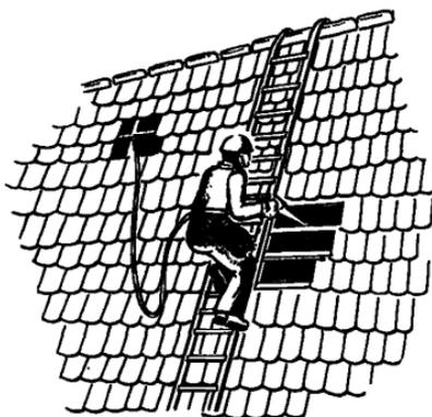
Рис. 11. Устройство проема в обрешетке
