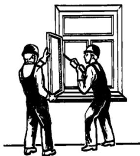
Рис. 40. Снятие оконных переплетов
