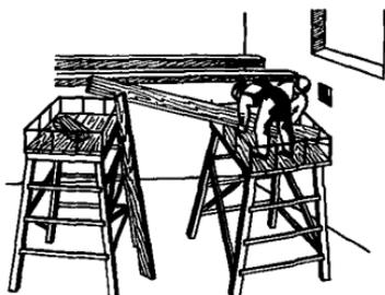
Рис. 25. Опускание перепиленной балки на подмости
