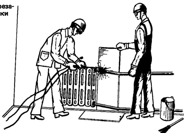
Рис. 56. Перерезание обратной подводки
