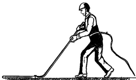
Рис. 9. Снятие карнизного свеса
