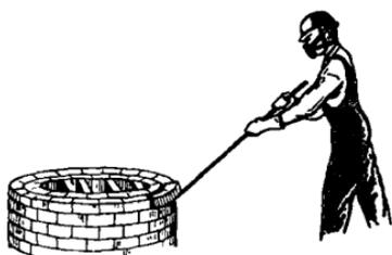
Рис. 46. Разборка кирпичной кладки
