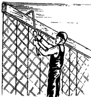
Рис. 37. Отрыв брусков обвязки
