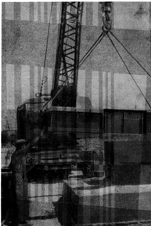
Рис. 23. Снятие блок-формы конструкции инж. Зуйченко
