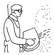
Штукатуры Ш<sub>1</sub> и Ш<sub>2</sub> работают самостоятельно. Каждый из них берет левой рукой пневматичес-кую машинку, ставит ее в наклонном положении на ведро загрузочным отверстием вверх, а правой рукой ковшом набирает из ведра приготовленный раствор и наполняет им бак машинки на 2/3 его объема. Затем штукатуры становятся вполоборота к стене на расстоянии 80-100 см
