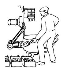
ведра и при помощи установленного на лесах ручного крана подает их к месту работ
