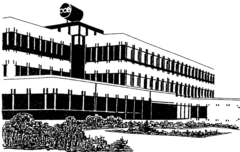
Рис. 30. Размещение бака для воды на кровле здания. Административное здание в Хертогенбоше (Нидерланды)
