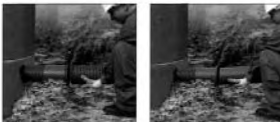
Соединение «бетонный колодец – труба Pragma®» в разрезе
