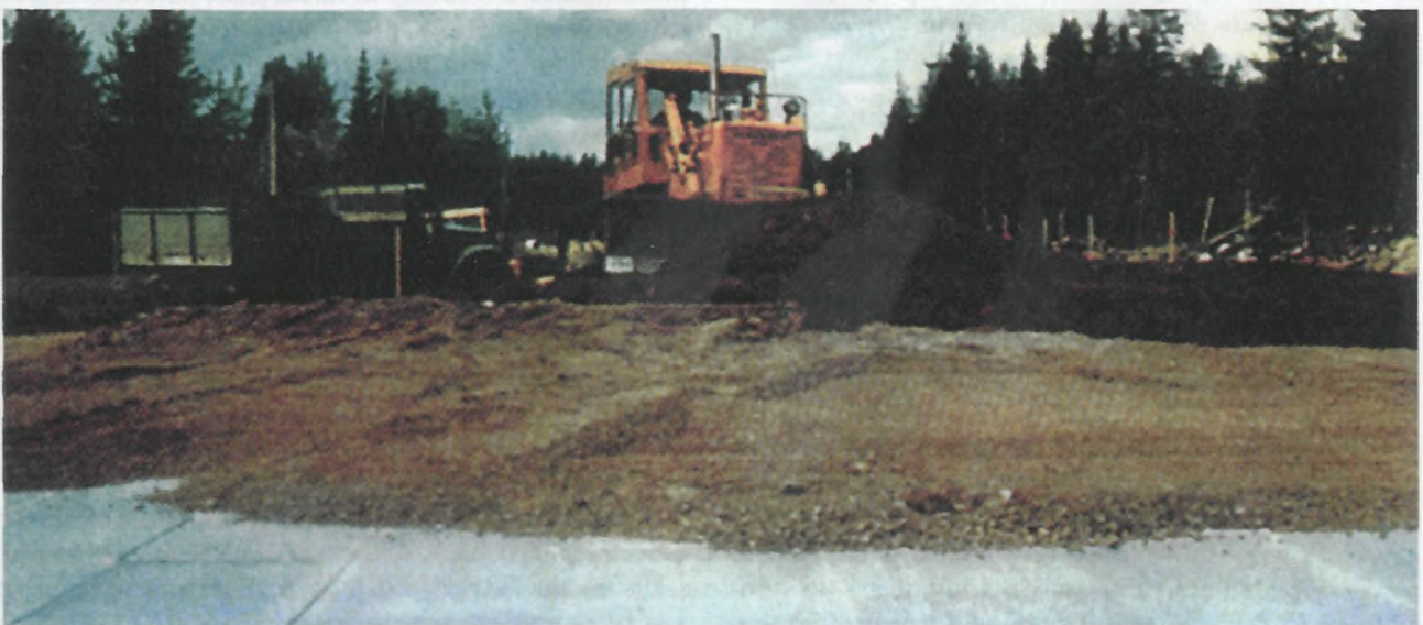
Рис. 8.3 — Укладка песка или щебня способом «от себя» по геопенопласту «Стайрофом»
