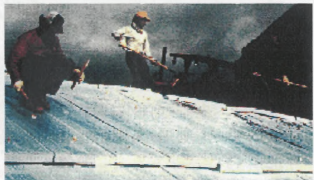
Рис. 7.14 — Монтаж геопенопласта «Стайрофом» на земляной дамбе
