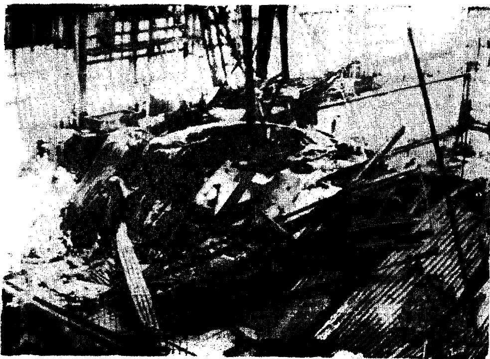
Рисунок В.51 – Вид машинного зала Сырдарьинской ГРЭС после аварии турбины К-300-240 (ст. № 7) ЛМЗ из-за коррозионно-усталостного разрушения рабочих лопаток последних ступеней ЦНД
